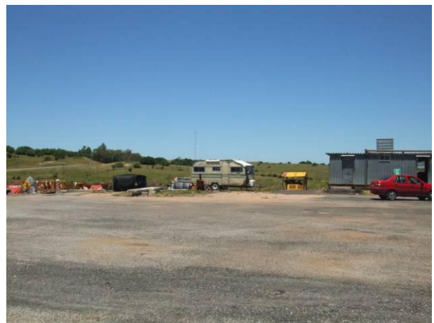
Ilustración 13 - Zona de trabajo sin señalizar
