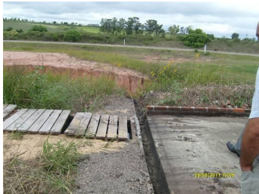
Ilustración 12 - Plataforma de lavado de maquinaria con sedimentador y trampa de aceites y grasas
