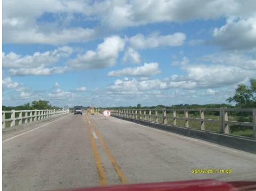
Ilustración 4 – Reparación de baranda en puente Aº Don Esteban
