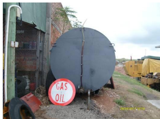
Ilustración 9 - Depósito de gasoil sin protección contra derrames
