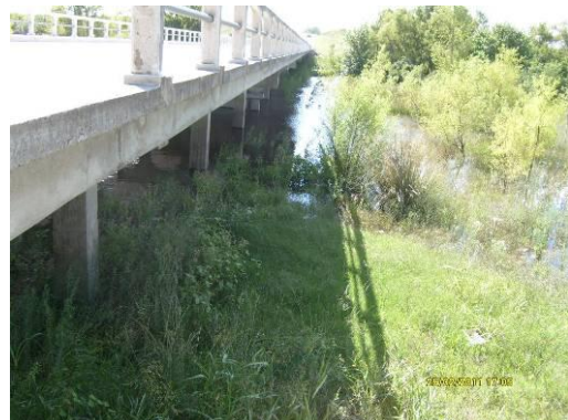
Ilustración 21 - Puente sobre Aº Las Flores sin signos de erosión
