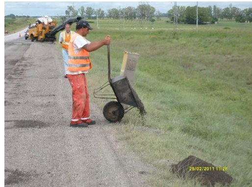
Ilustración 13 - Residuos finos del fresado siendo depositados en el talud al borde de la banquina
