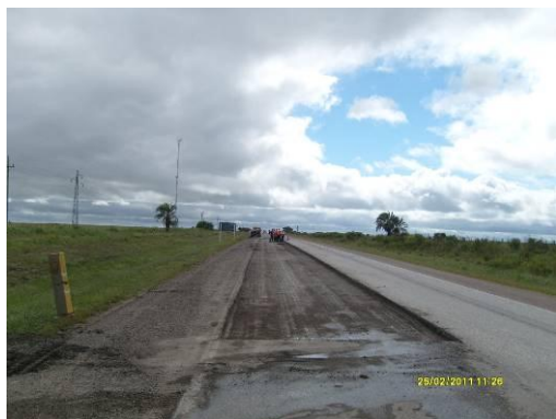
Ilustración 14 - Pavimento fresado, antes de recibir la mezcla asfáltica
