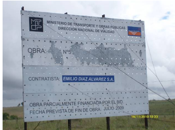
Ilustración 12 – Cartel de inicio en malas condiciones
