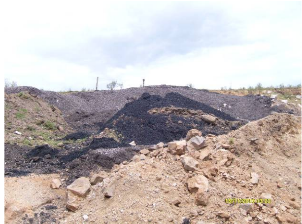
Ilustración 6 – Acopio transitorio de residuos de materiales asfálticos en predio de la cantera de tosca
