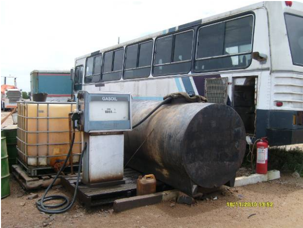
Ilustración 5 – Tanque de combustible sin obra de contención de derrames
