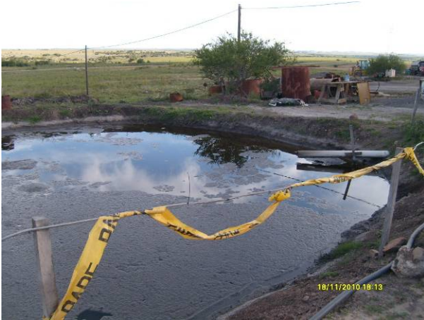
Ilustración 11 – Sedimentador asociado a planta asfáltica
