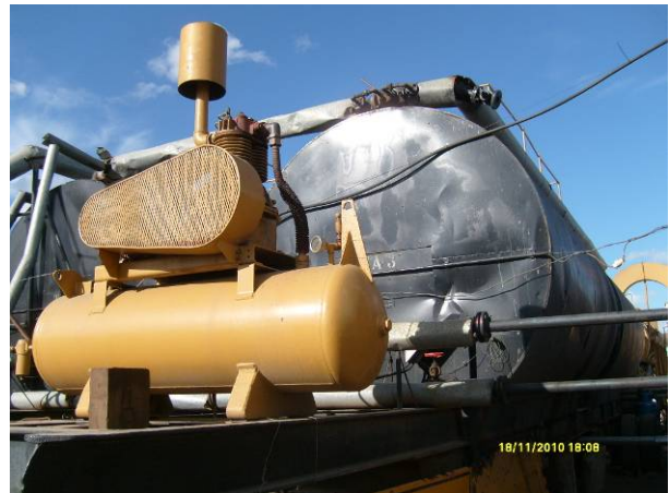
Ilustración 14 – Tanques de combustible de planta asfáltica sin diques protectores de derrames
