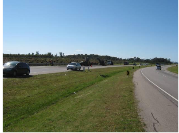
Ilustración 12 - Vista general del Fresado.
