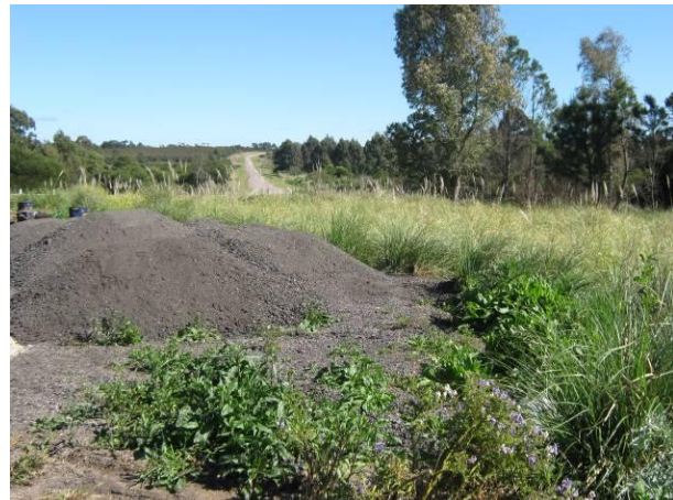
Ilustración 10 - Acopio transitorio en tareas de fresado
