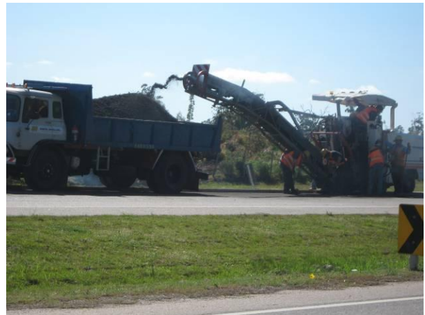
Ilustración 14 - Carga del material en camión
