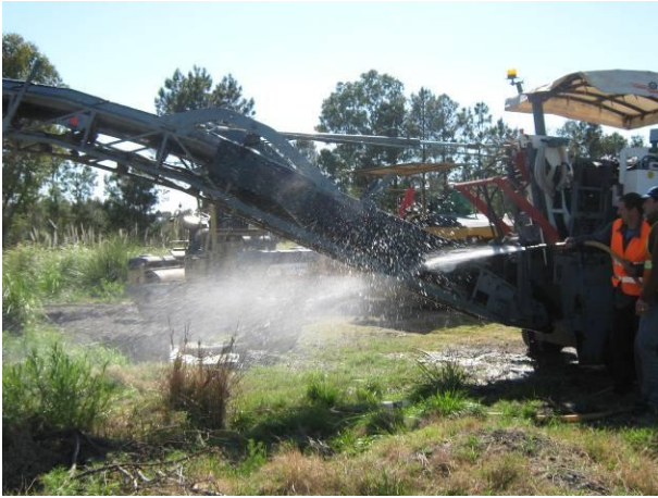
Ilustración 11 - Lavado de la Fresadora en el campamento
