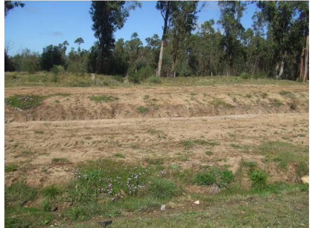
Ilustración 18 - Talud sin vegetación
