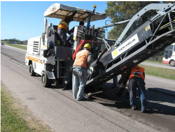
Ilustración 13 - Fresado y operarios recogiendo material
