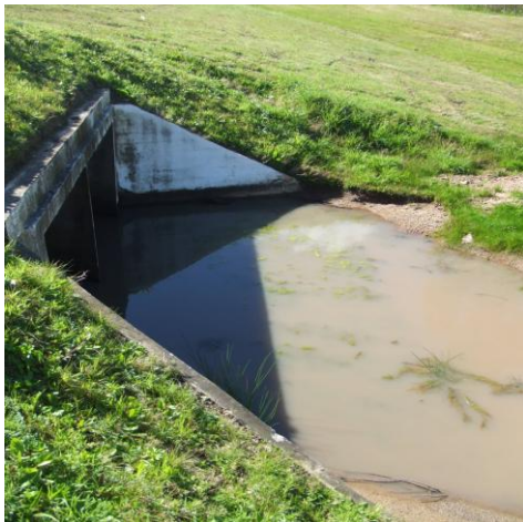
Ilustración 19 – Mal manejo de drenajes
