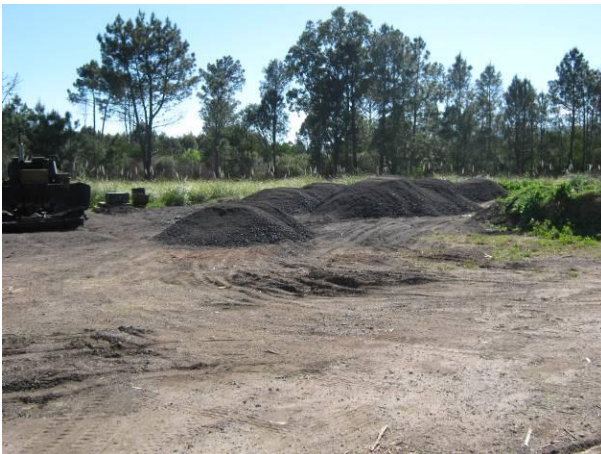
Ilustración 9 - Acopio transitorio en tareas de Fresado
