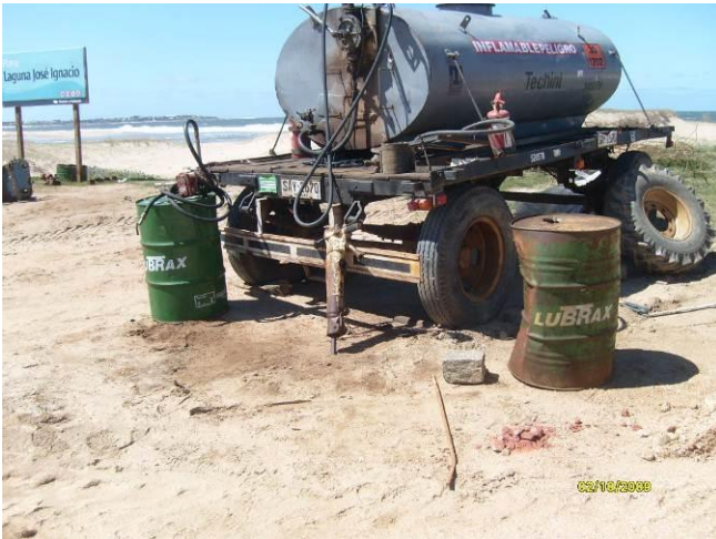
Ilustración 3 (No conformidad 1) – Tanque de combustible sin “diques” de contención
