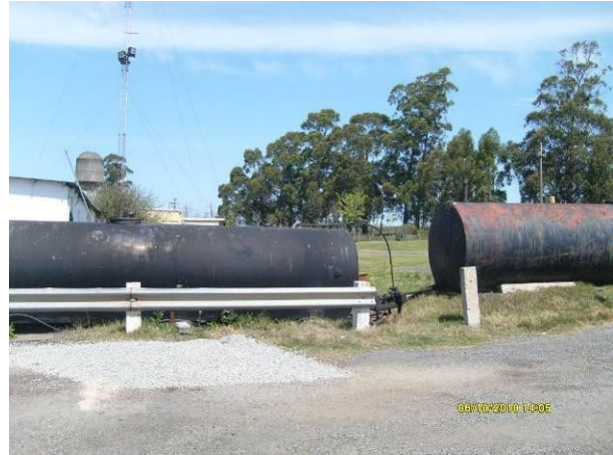
Ilustración 18 - Tanques de combustibles sin contención ante derrames
