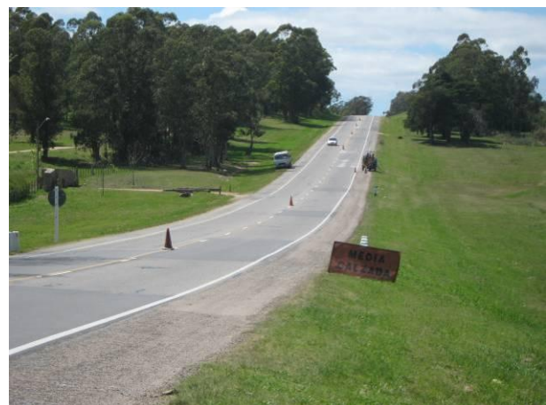
Ilustración 10 - Sellado de fisuras señalización
