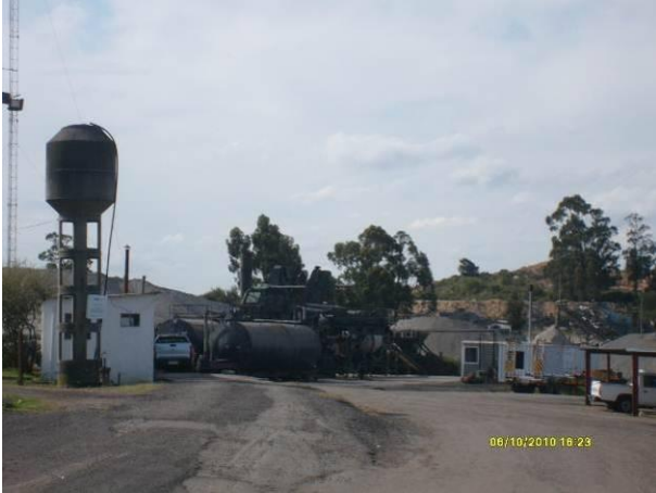
Ilustración 5 – Obrador con planta asfáltica y trituradora
