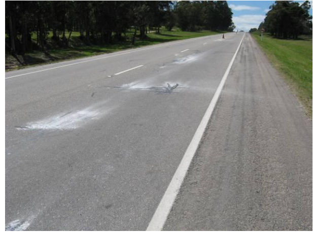
Ilustración 12 - Fisuras selladas
