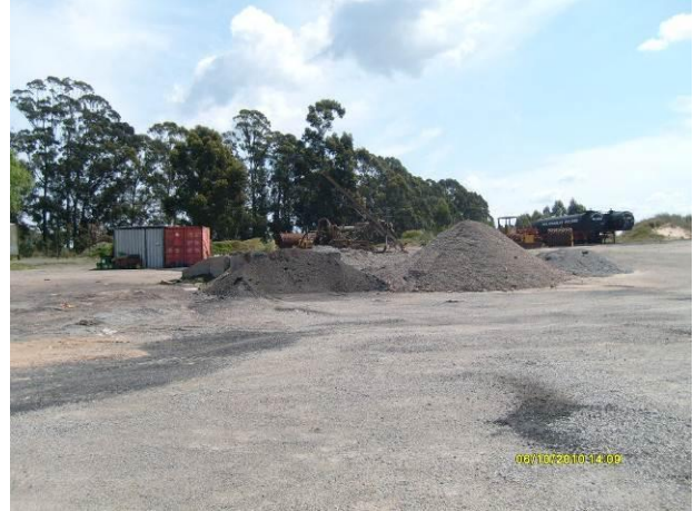
Ilustración 6 – Acopio de materiales en el obrador
