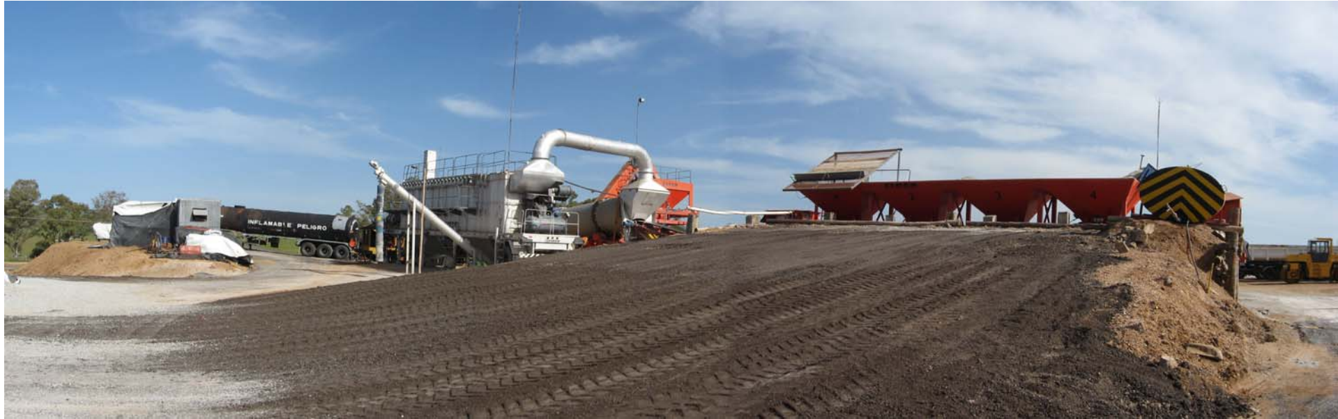
Vista general de rampa de carga de áridos a la planta de asfalto
