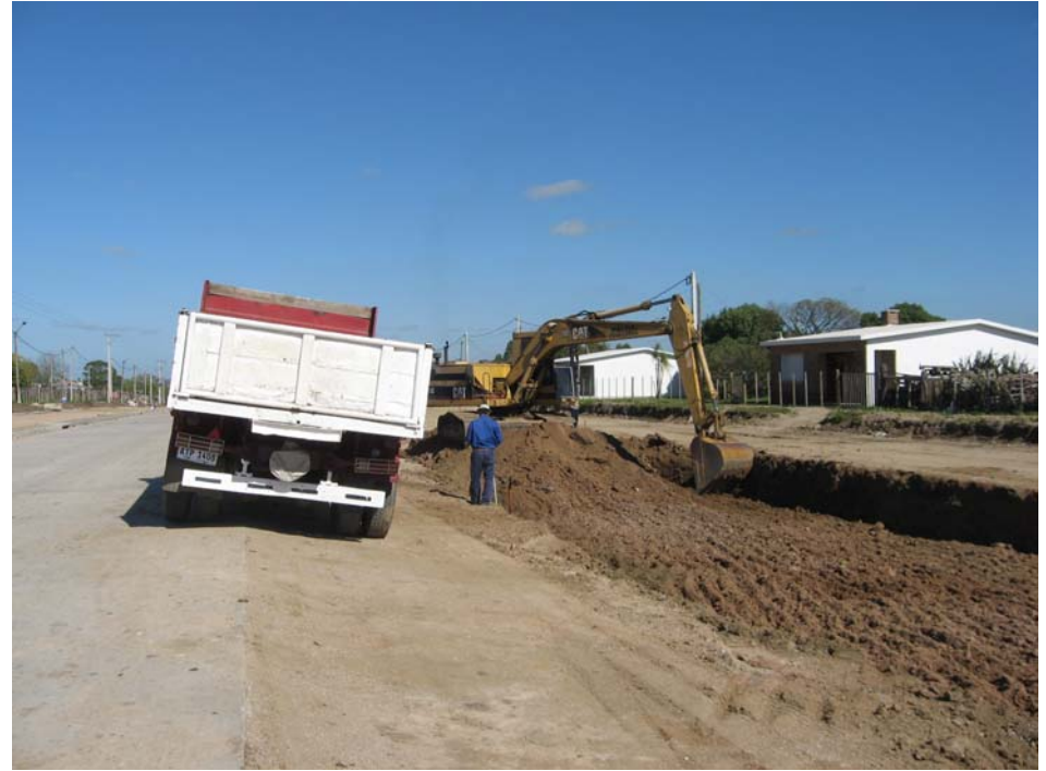
Movimiento de suelos segunda calzada
