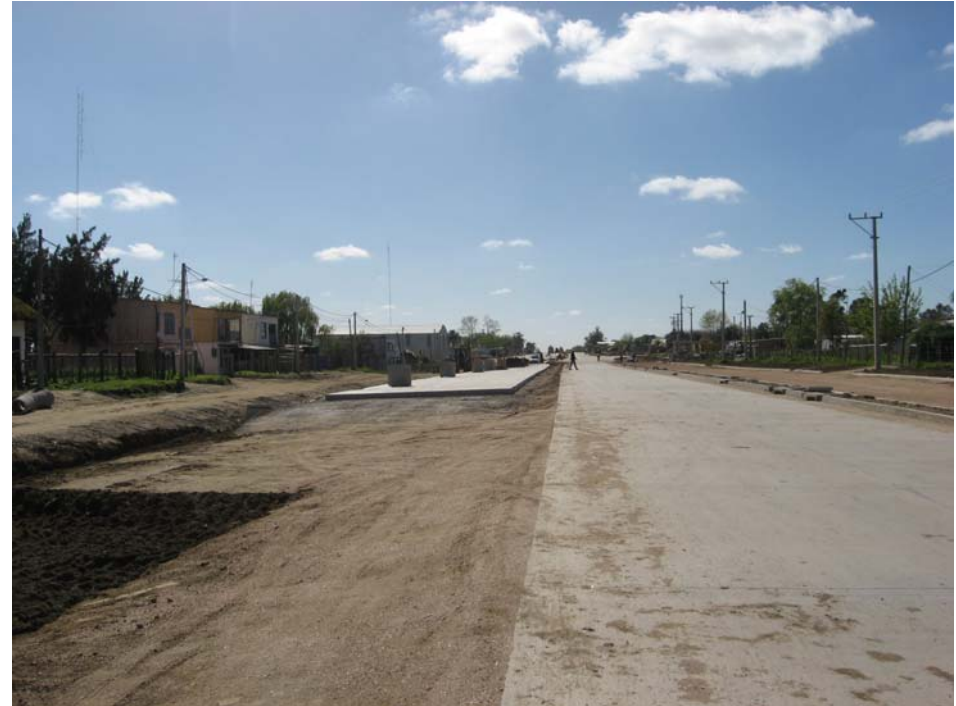
Pavimentación en hormigón segunda calzada
