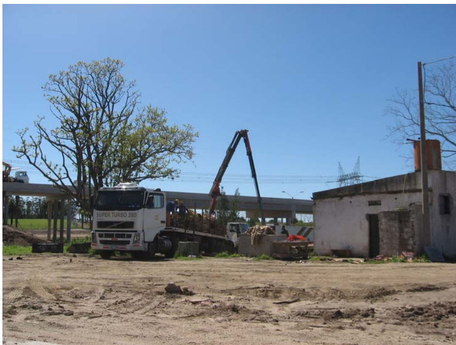
Desmovilización de pequeño obrador de la firma Saceem
