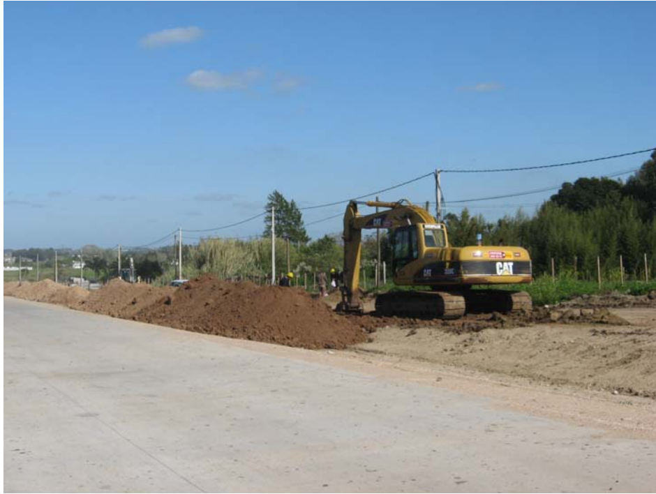
Movimiento de suelos segunda calzada
