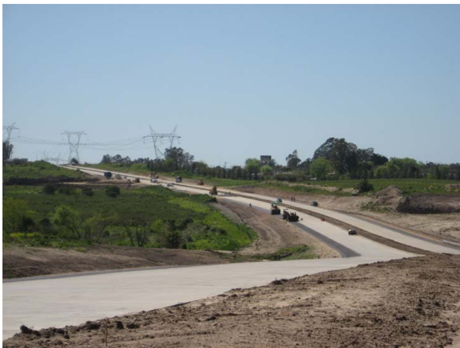
Vista general de la construcción de la segunda calzada entre el arroyo Manga y la Ruta 8
