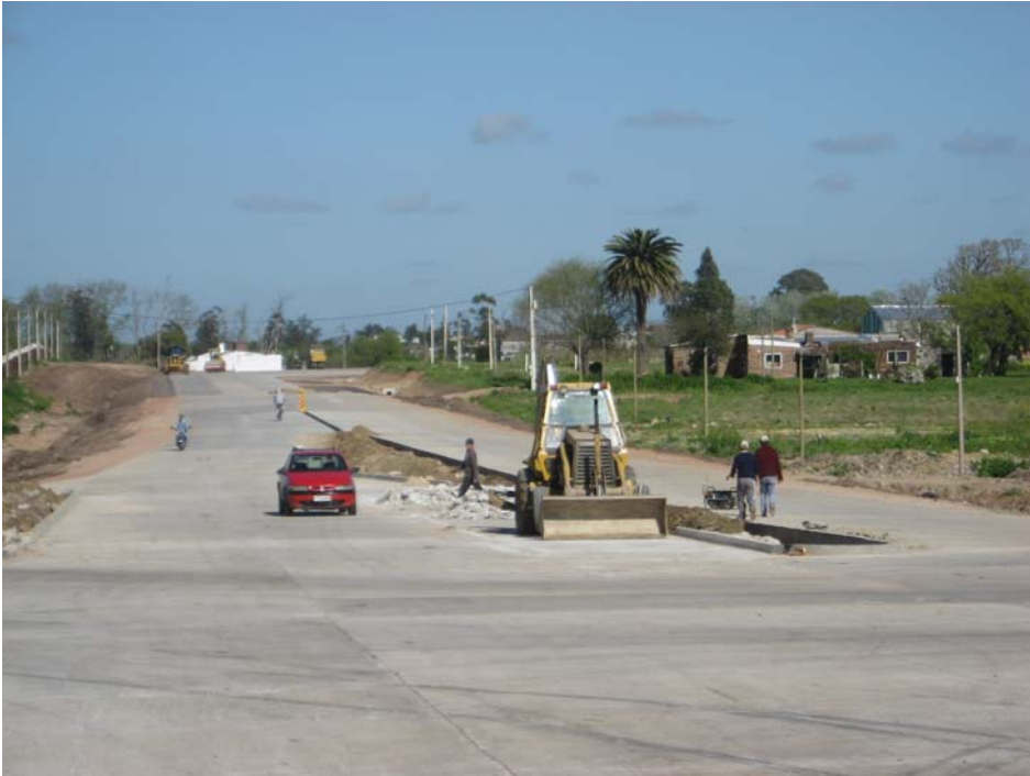
Trabajos en canteros
