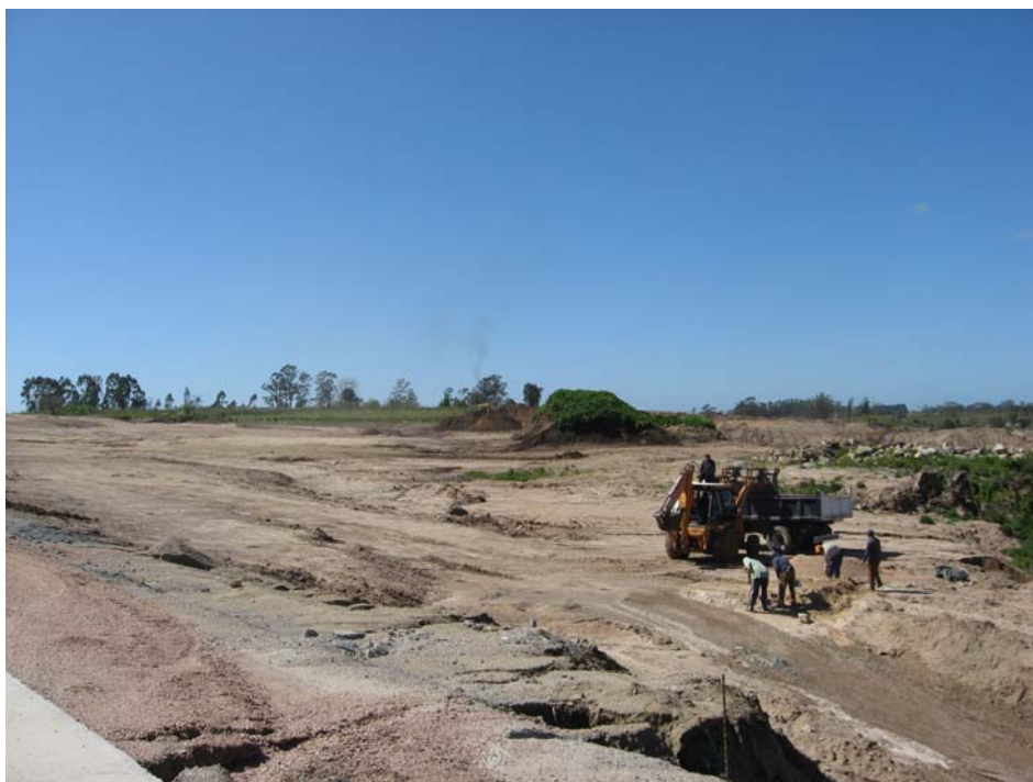
Sitio de préstamos cercana a arroyo Manga aguas abajo del puente en restauración
