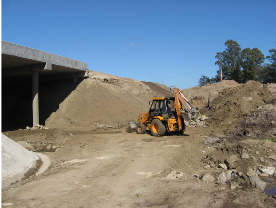
Movimiento de suelos en arroyo Manga
