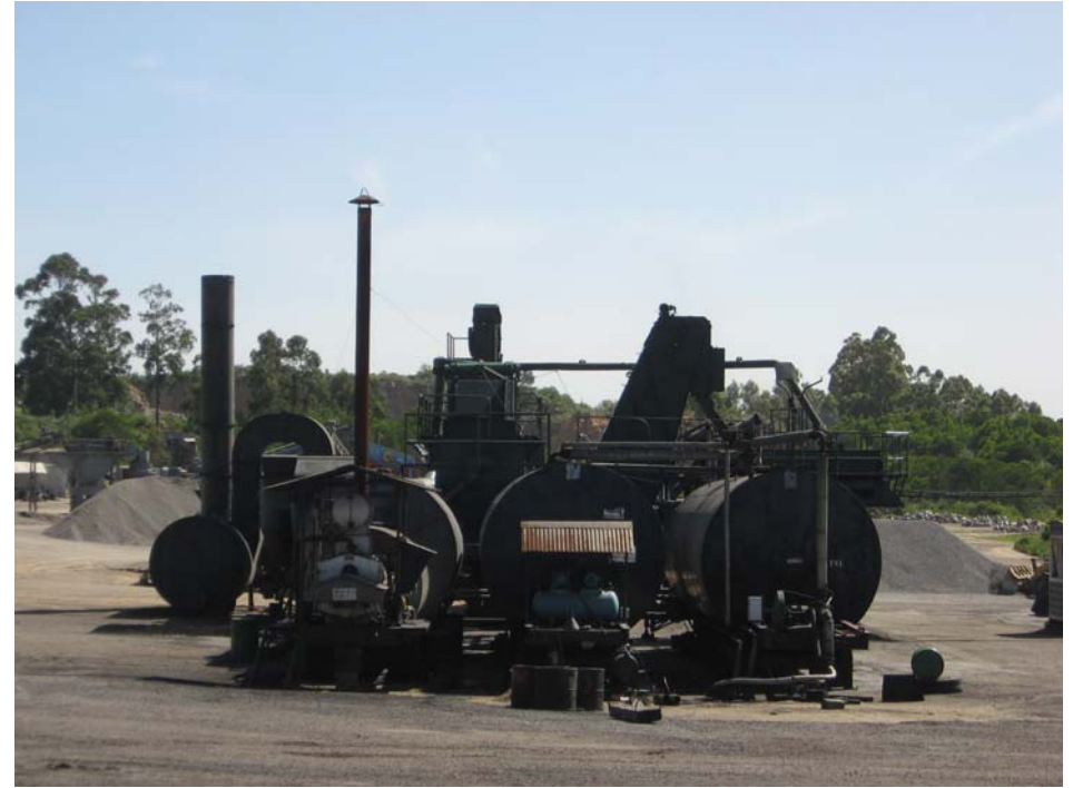
Planta de mezcla asfáltica
