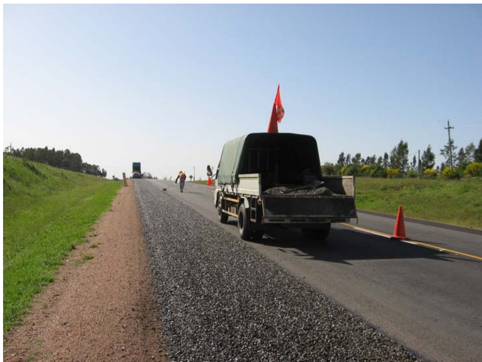
Tratamiento bituminoso de banquina
