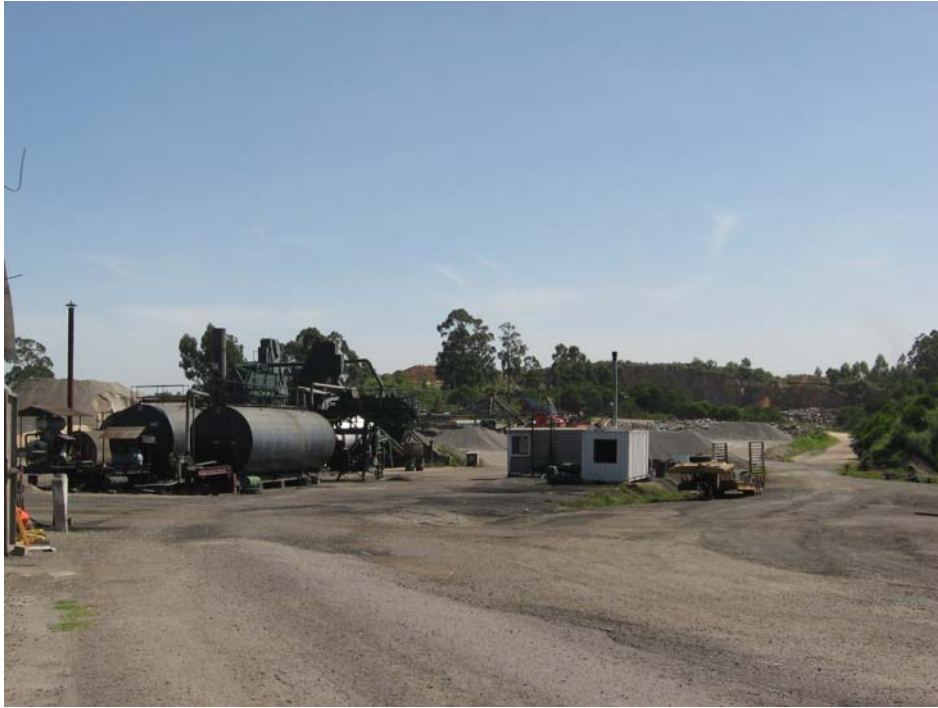
Vista del obrador: planta de mezcla asfáltica y trituradora al fondo
