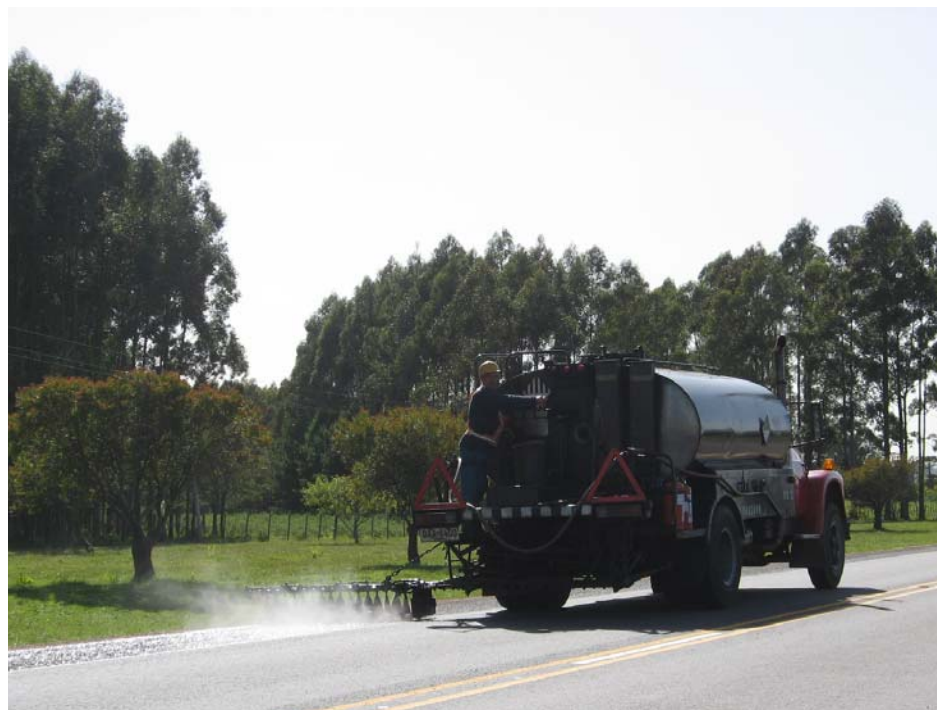
Tratamiento bituminoso de banquina
