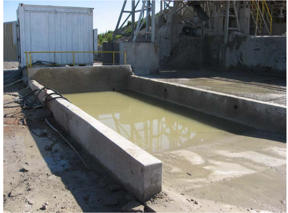
Pileta de sedimentación de lavado de camiones mixers (obrador CVC)
