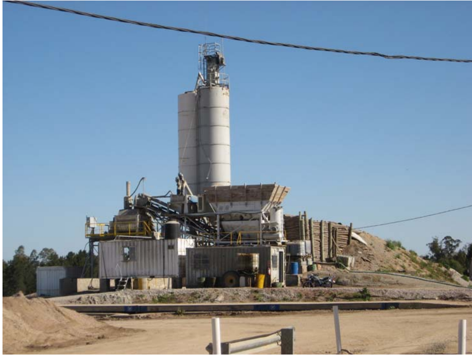
Planta de hormigón en obrador de CVC
