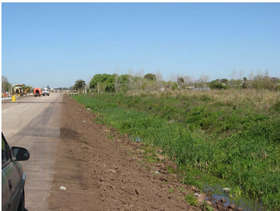
Vista general de drenaje y taludes
