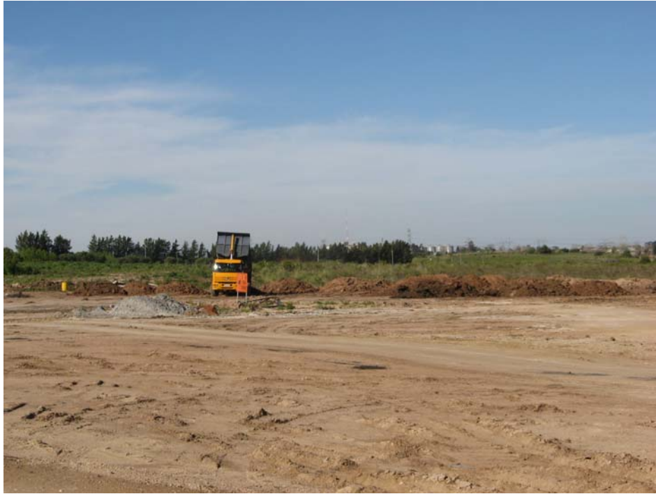
Relleno en obrador de CVC
