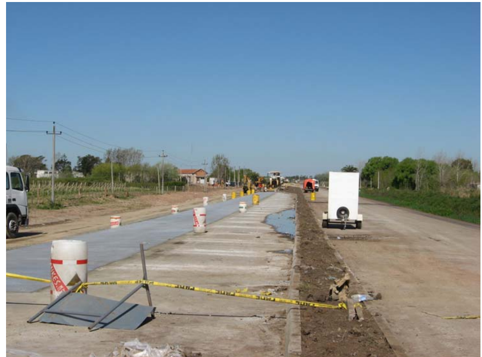
Pavimentación en la vía Norte
