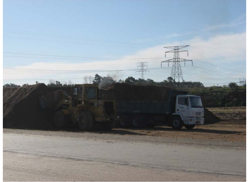
Acopios de tierra vegetal
