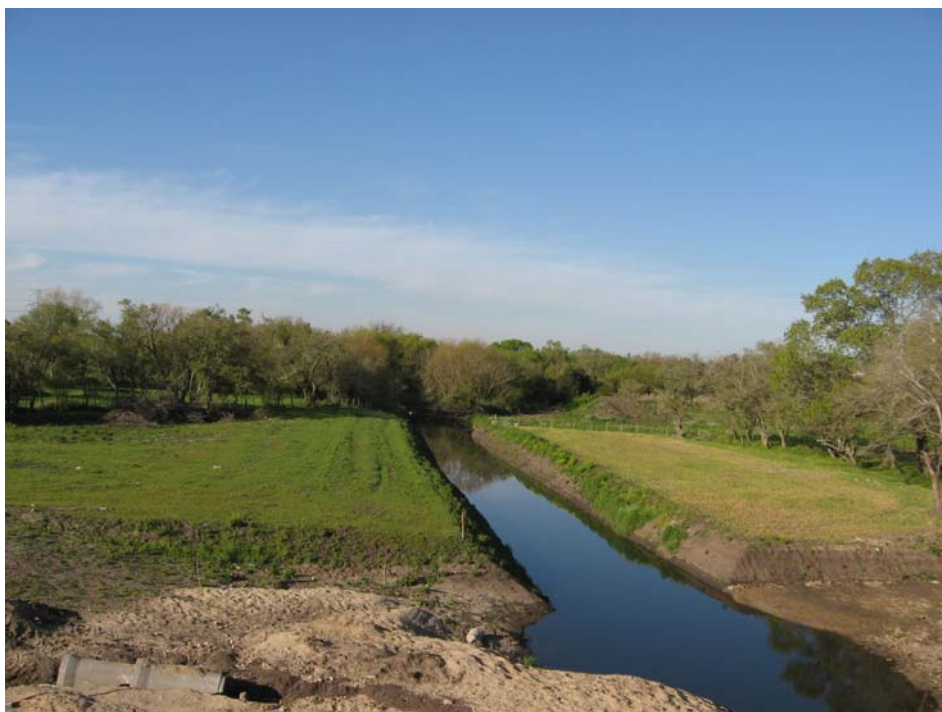
Canalizaciones del arroyo Mendoza sentido a(-)
