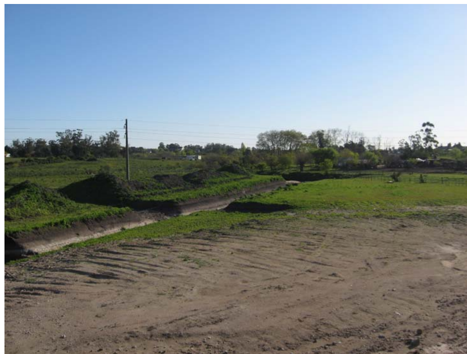
Canalizaciones del arroyo Mendoza sentido a(+)
