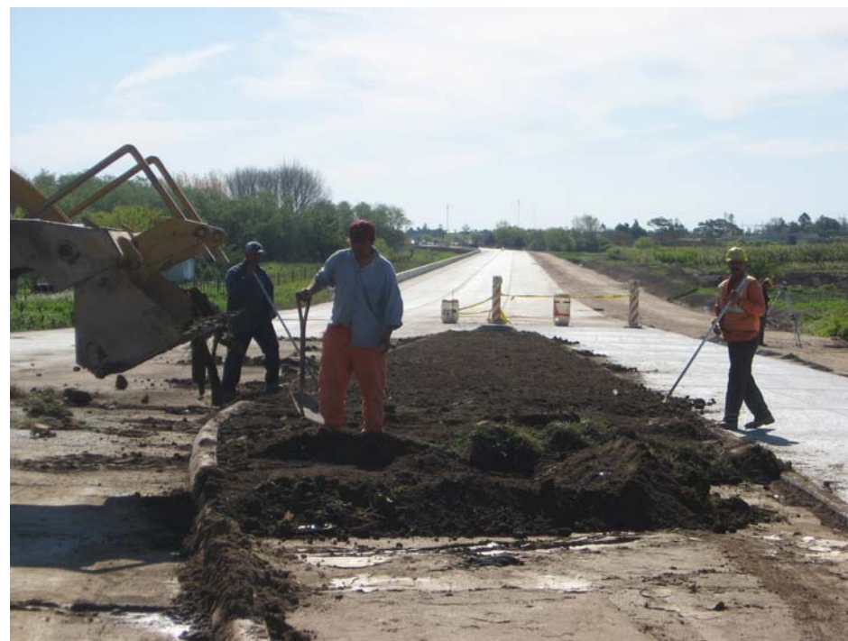
Trabajos en canteros
