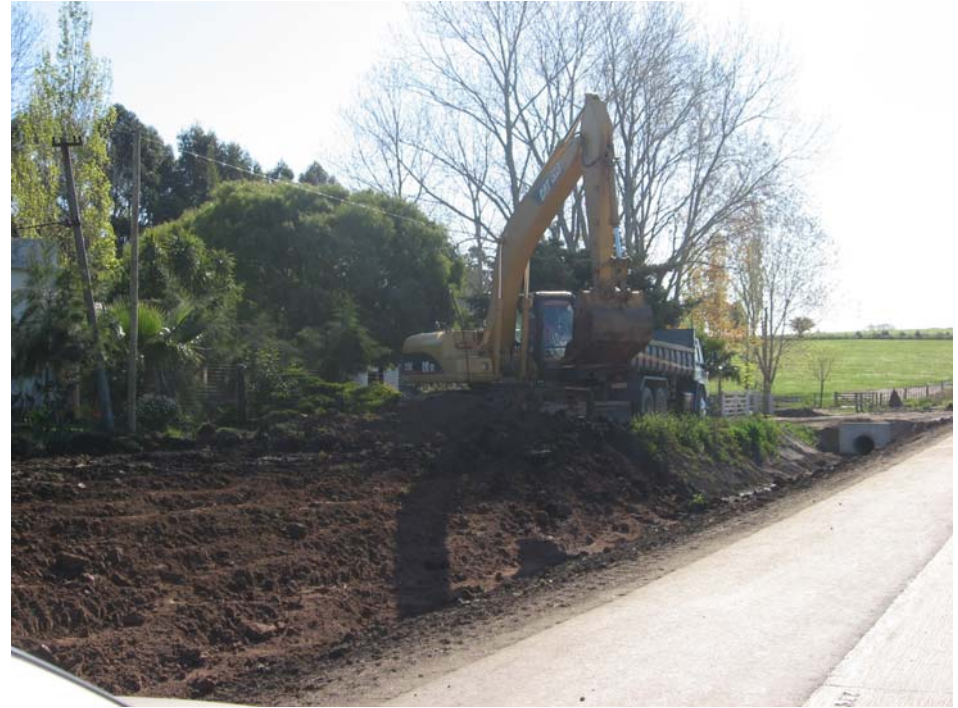
Regularización de taludes
