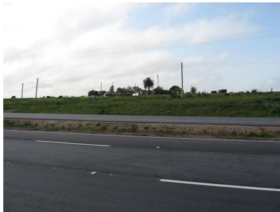
Ausencia de cobertura vegetal en drenaje central de ambas vías
