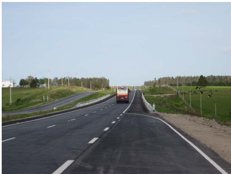
Vista general de la vía
