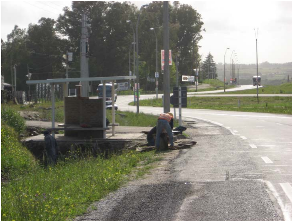
Parada en construcción
