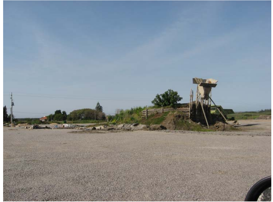
Obrador Arnel, desmovilización de obrador
