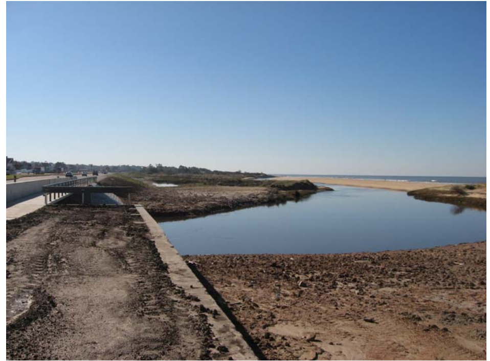
Vista de desembocadura del arroyo (márgenes regularizadas)
