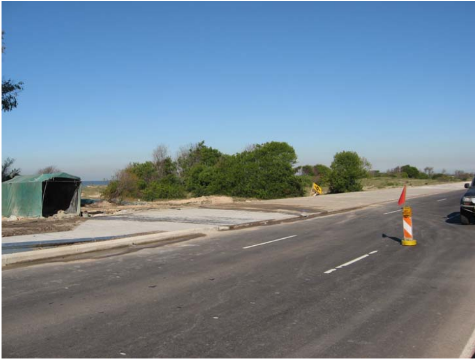
Vista de zona donde se encontraba obrador
