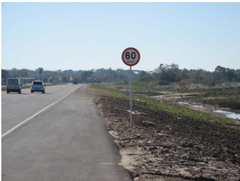
Vista hacia el Este, taludes con cobertura vegetal
