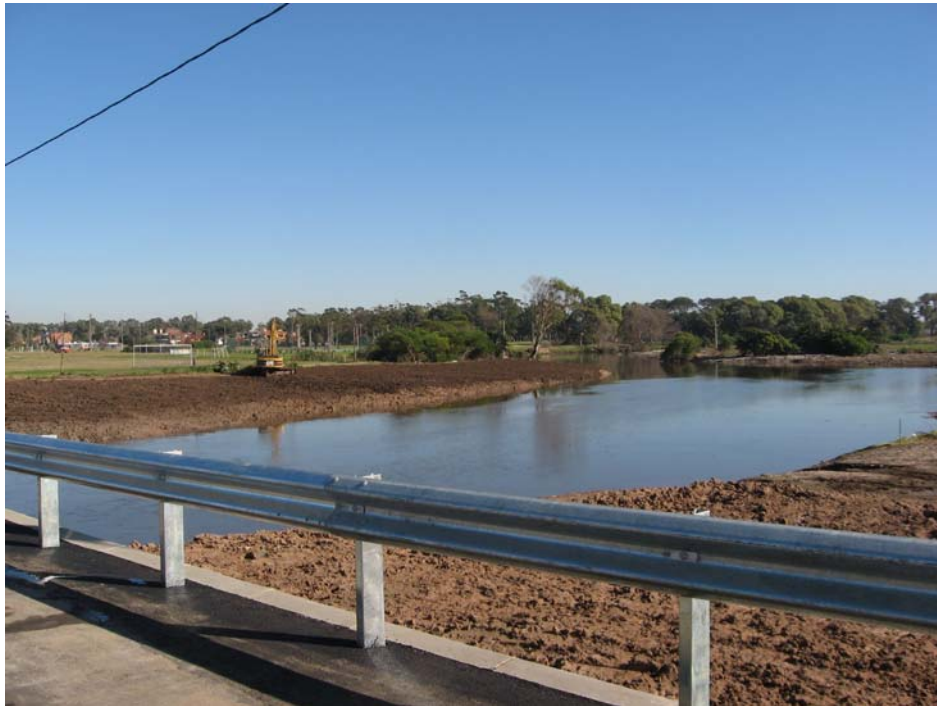
Vista general hacia aguas arriba del puente
