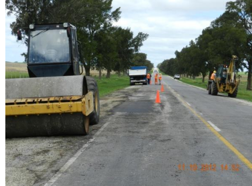
Ilustración 5: Bacheo en pavimento con mezcla asfáltica
