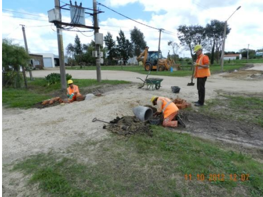
Ilustración 4: Construcción de alcantarillas
